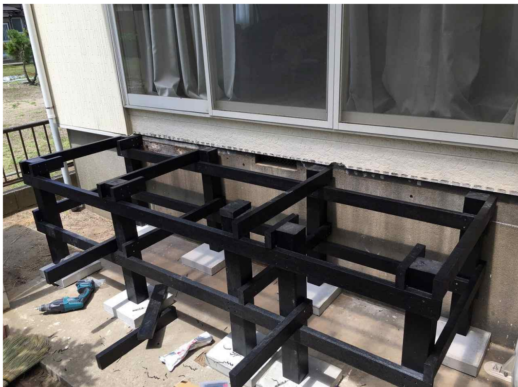
大引き・束 下地施工図
